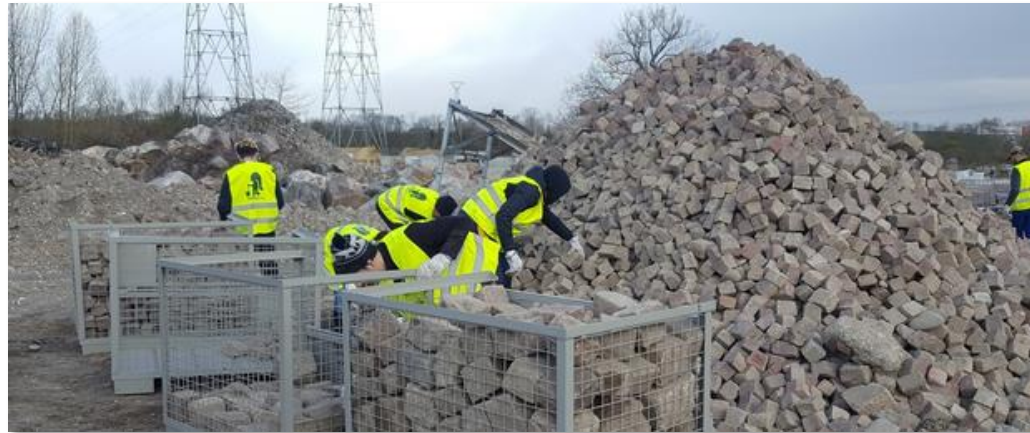
Chantier Tapaj « voierie »
